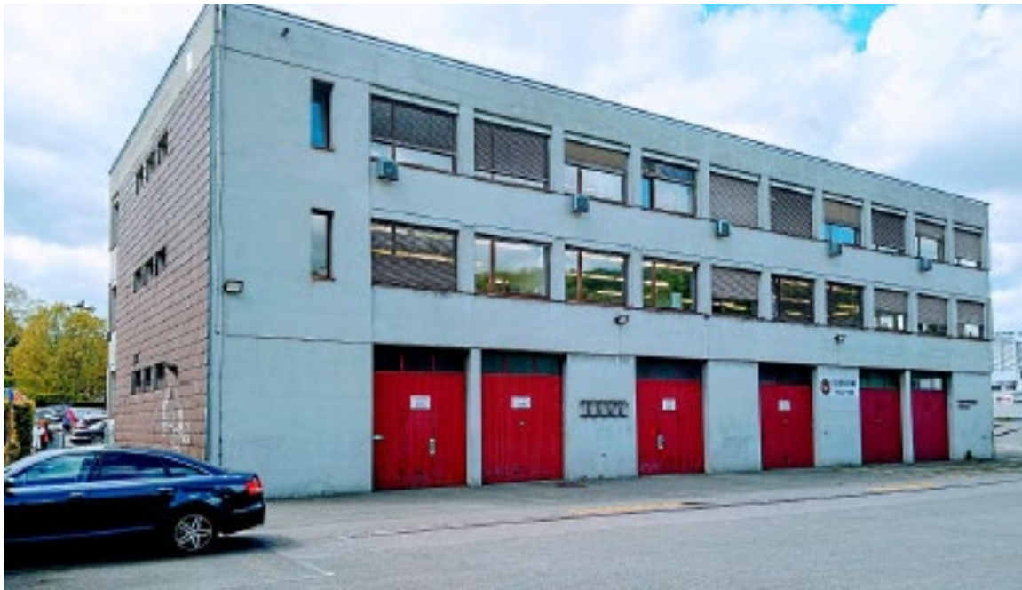
Süd / Ost Fassade
