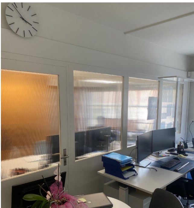
Holztrennwand mit Einscheibenglas-Einsätzen
