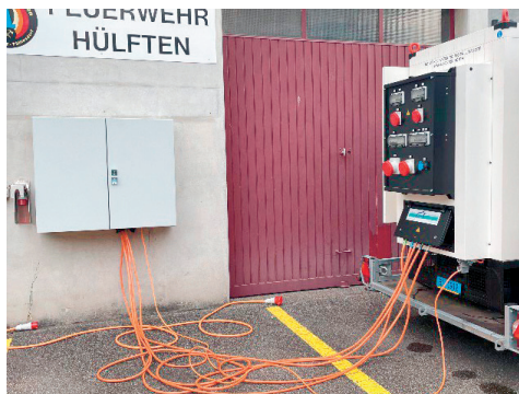
Notstromaggregat GWP-Niederschönthal
